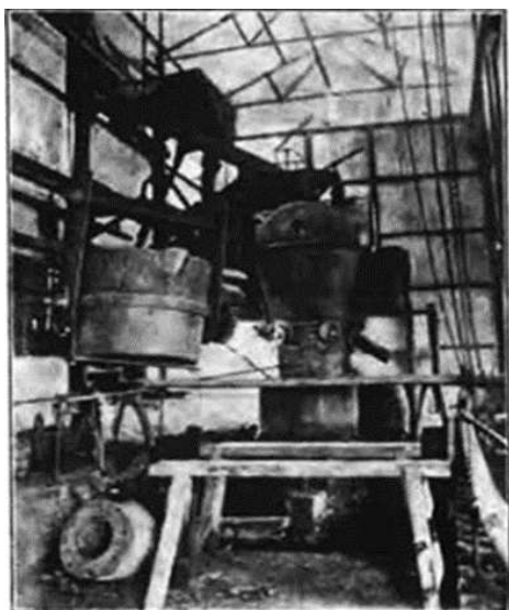
Рис. 4. Первый аппарат для хлорирования металлической руды «трансформер»
